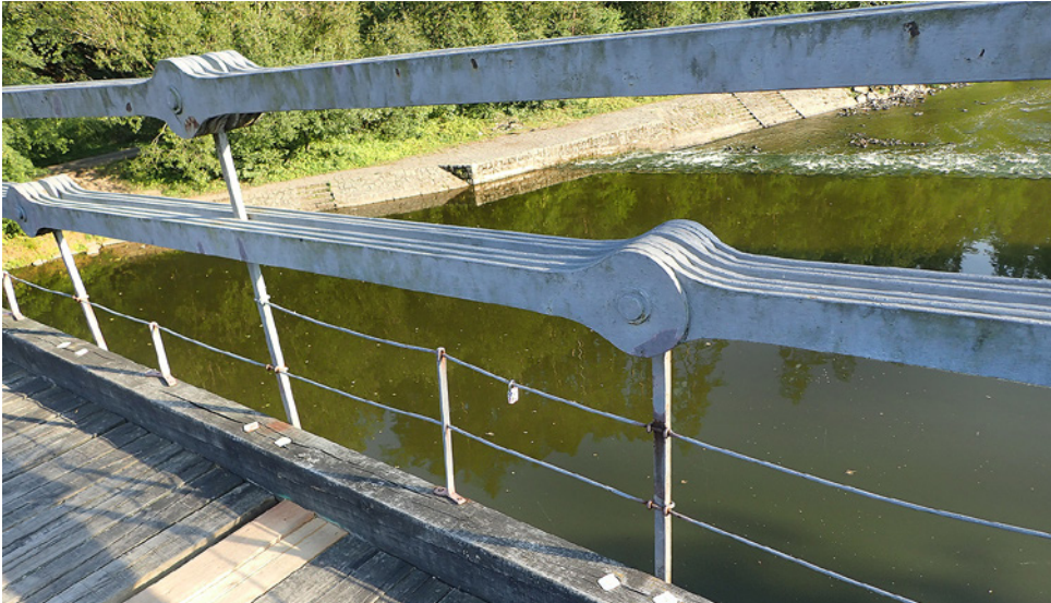
Obr. 3.60. Pohled na řetězy tvořící hlavní nosný systém mostu Fig. 3.60 View of the chains forming the main support system
