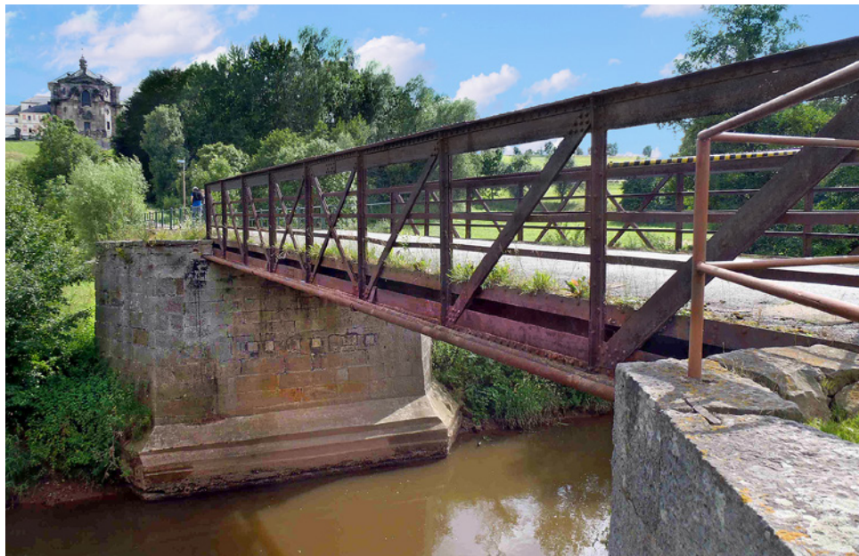
Obr. 3.78. Nosná konstrukce mostu před rekonstrukcí Fig. 3.78 Superstructure before reconstruction
