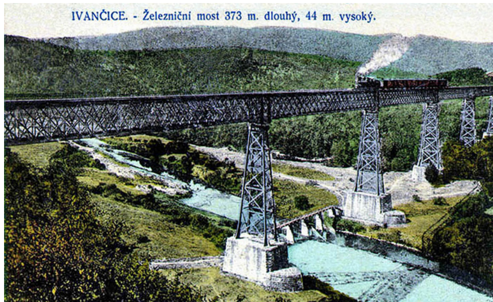
Obr. 1.20. Ivančický viadukt Fig. 1.20 Ivančice Viaduct
