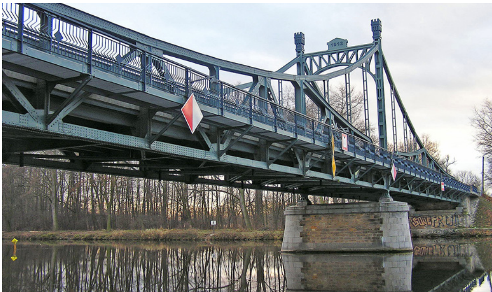
Obr. 3.117. Stav mostu po rekonstrukci v roce 2003 Fig. 3.117 Bridge after reconstruction in 2003
