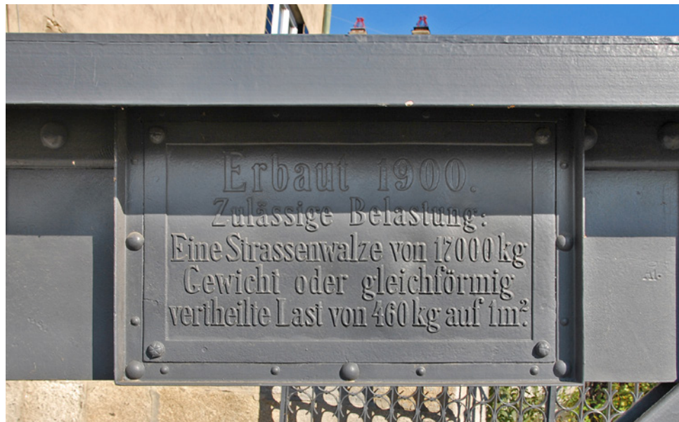
Obr. 3.95. Štítek s informacemi o přípustném zatížení v původním stavu konstrukce Fig. 3.95 Historical plate with information about the permissible load of the structure at that time
