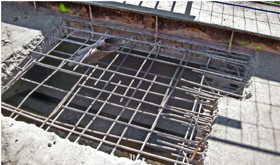
Obr. 3.163. Vybouraná část desky mostovky v rámci dodatečného diagnostického průřezu Fig. 3.163 Demolished part of the bridge deck slab
