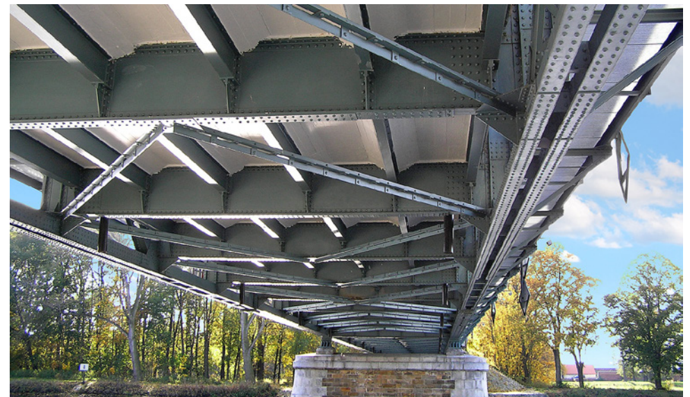
Obr. 3.118. Stav mostu po rekonstrukci v roce 2003 Fig. 3.118 Bridge after reconstruction in 2003
