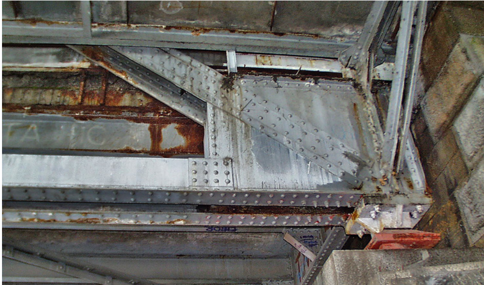
Obr. 3.115. Stav mostu před rekonstrukcí v roce 1998 Fig. 3.115 Bridge before reconstruction in 1998
