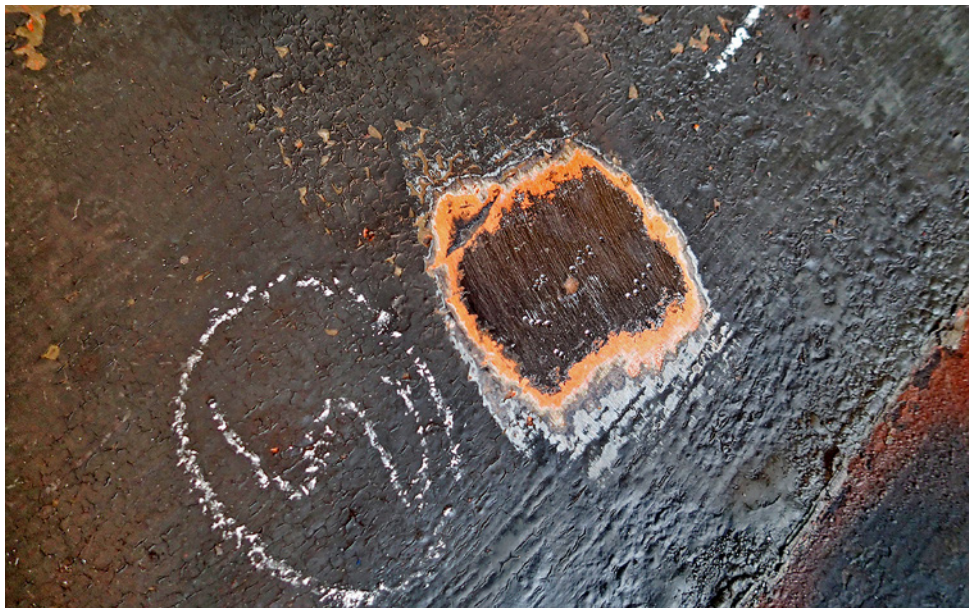
Obr. 1.50. Ukázka zásahu do historické konstrukce podle invazivnosti průzkumu; (a) neinvazivní průzkum – místo pro tvrdoměrnou zkoušku, (b) invazivní průzkum – místo odběru vzorku pro tahovou zkoušku
