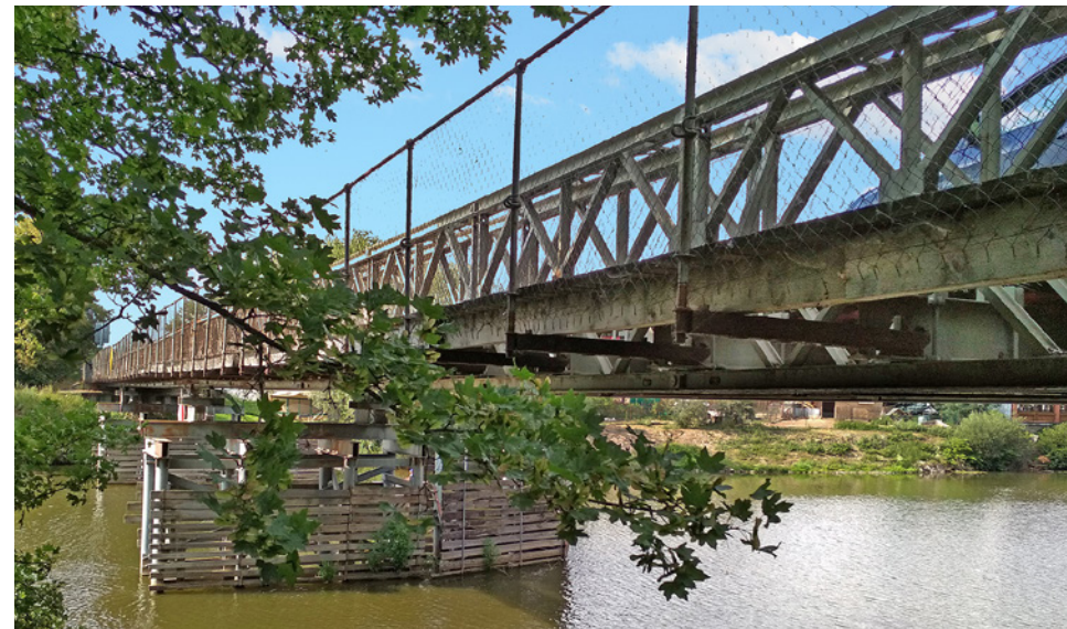
Obr. 3.148. Pohled na most z povodní strany Fig. 3.148 View of the bridge
