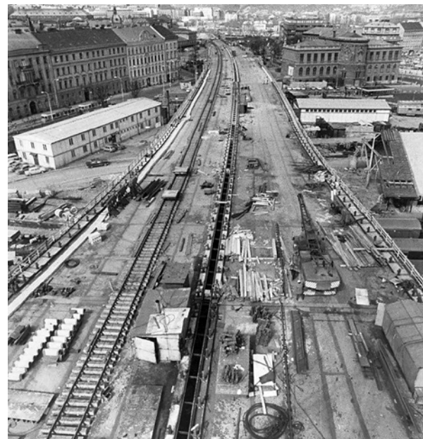
Obr. 1.44. Severojižní magistrála – letecký pohled od Hlavního nádraží směrem k Hlávkovu mostu (1975 až 1977) Fig. 1.44 North-South Main Line – aerial view from the Main Railway Station in the direction of the Hlávkov Bridge (1975 to 1977)
