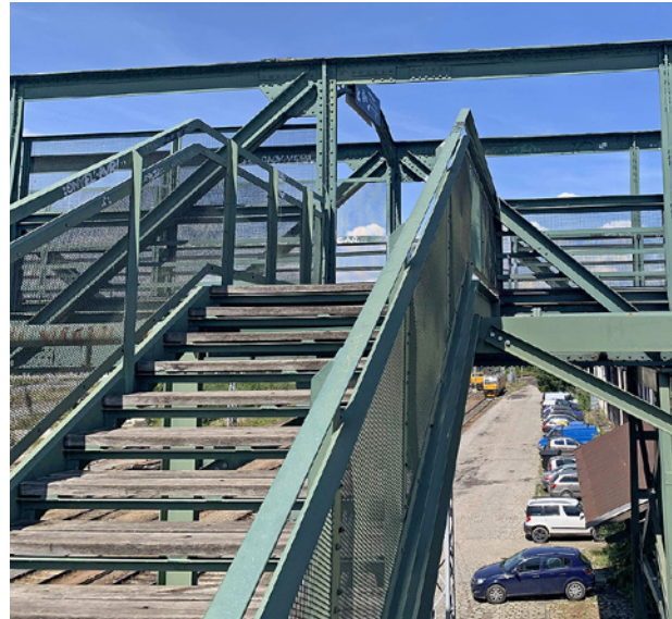
Obr. 3.171. Dodatečné přístupové schodiště a vyříznutá diagonála Fig. 3.171 Additional staircase from the northern platform
