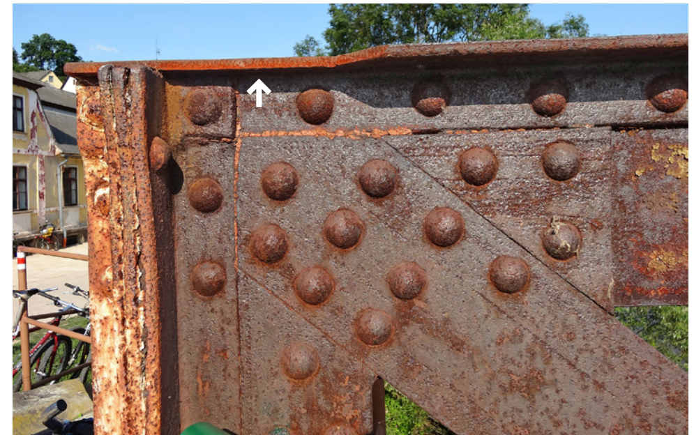
Obr. 3.79. Odběr vzorku z úhelníku horního pásu (vzorek č.2) Fig. 3.79 Location of the sample of upper chord angle member (sample n.2)
