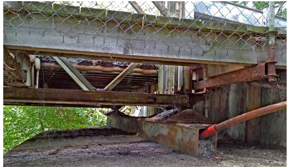
Obr. 3.152. Usazování nečistot u ložiska a na úložném prahu Fig. 3.152 Dirt and dust near the bearing
