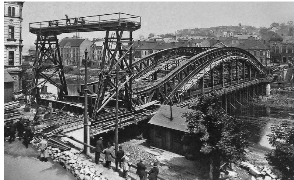
Obr. 3.127. Nový most před dokončením Fig. 3.127 The new bridge before completion
