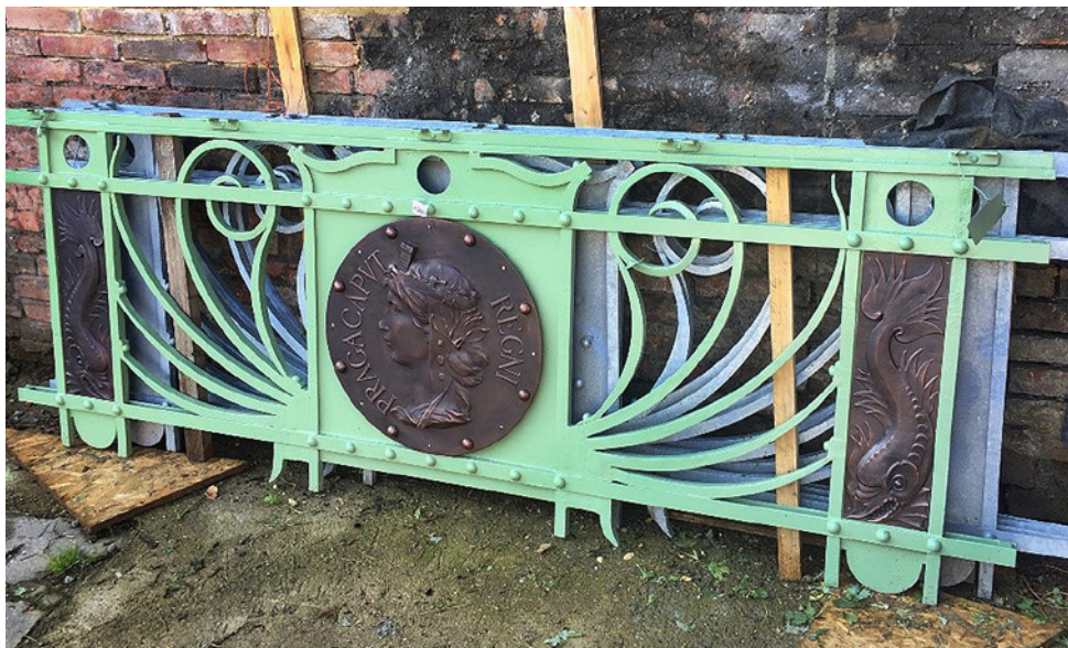
Obr. 1.55. Aplikace systému protikorozní ochrany segmentu zábradlí Čechova mostu Fig. 1.55 Application of the corrosion protection system for the railing segment of the Čech Bridge
