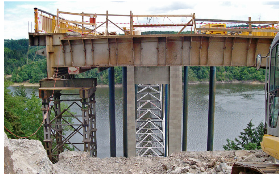
Obr. 3.166. Koncový příčník před rekonstrukcí Fig. 3.166 End crossbeam before reconstruction
