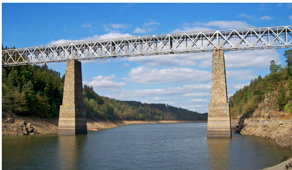
Obr. 1.29. (a, b) Příhradový most s mezilehlou mostovkou. Most s vloženým polem (železniční most u Červené nad Vltavou z roku 1889)
