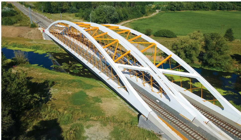
Obr. 1.34. (a, b) Tuhý trám vyztužený obloukem, tzv. Langerův trám, se síťovými závěsy (železniční most přes Dyji na trati Hohenau–Přerov z roku 2016, tzv. Oskar, foto David Rose)
