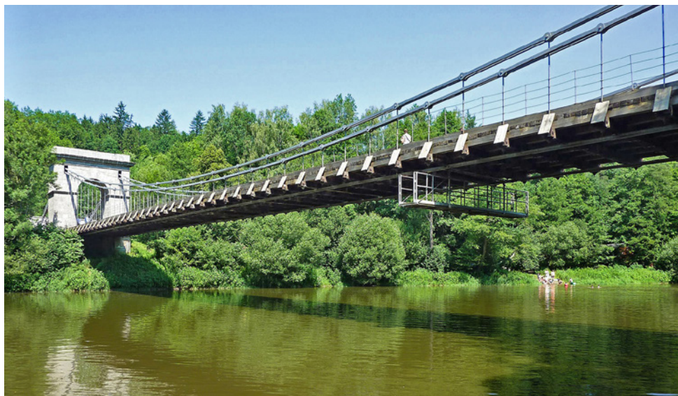
Obr. 1.36. (a, b) Řetězový silniční most, původní most v Podolsku přes Vltavu byl z roku 1848, v roce 1960 byl rozebrán a přemístěn do Stádlce přes Lužnici, uveden do provozu byl v roce 1974.
