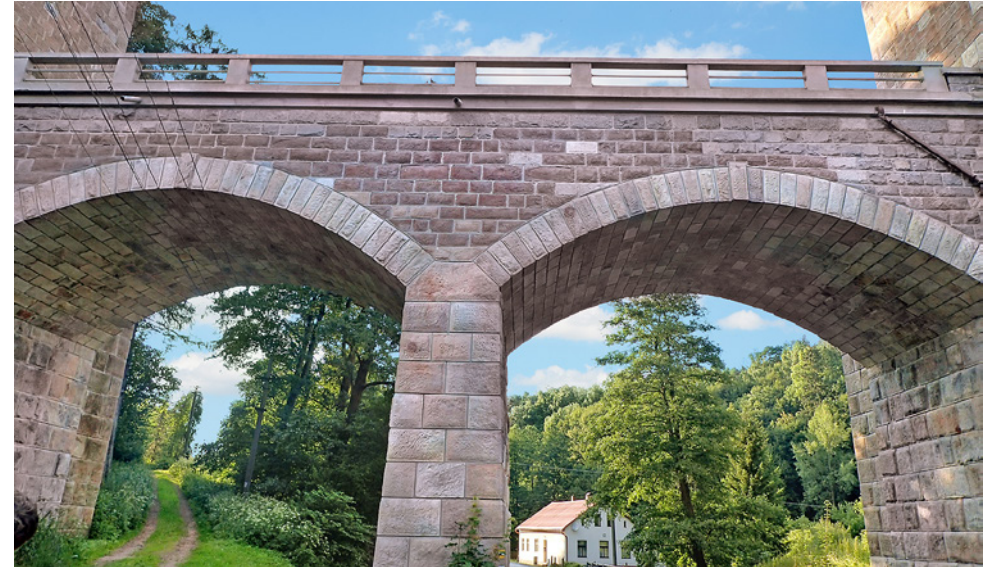
Obr. 3.51. Rozpěrné klenby v dolní části spodní stavby Fig. 3.51 Vaults in the lower part of the substructure
