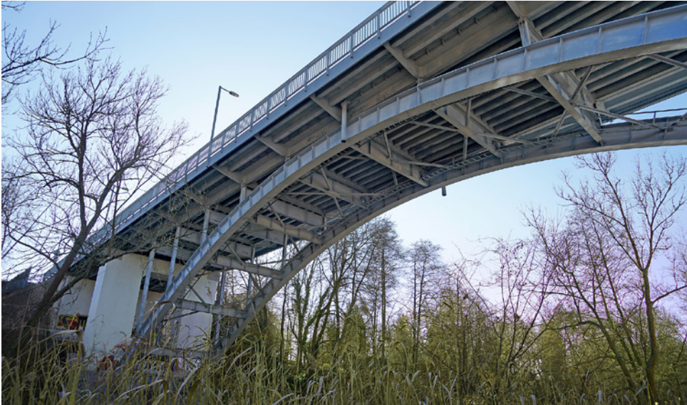
Obr. 3.136. Pohled na oblouk a mostovku z východu v roce 2021 Fig. 3.136 View on the arch from the east in 2021
