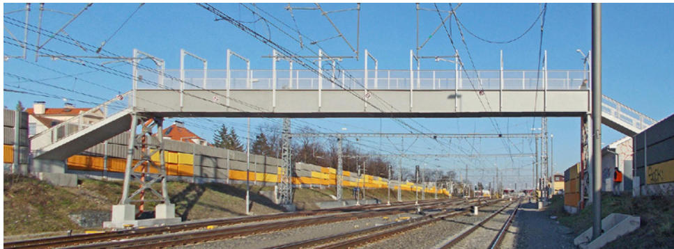
Obr. 1.22. (a, b) Plnostěnný most s dolní mostovkou (lávka v Praze Hostivaři z roku 1937)
