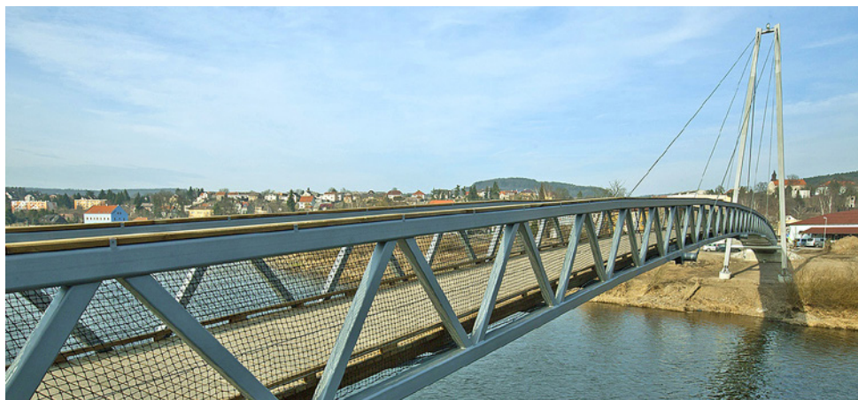
Obr. 1.35. (a, b) Most s vějířovým uspořádáním závěsů (lávka v Hýskově přes Berounku z roku 2014)
