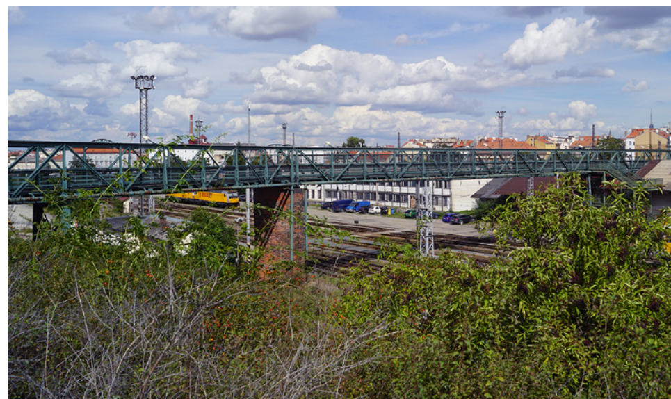
Obr. 3.169. Celkový pohled na most Fig. 3.169 The view on the bridge
