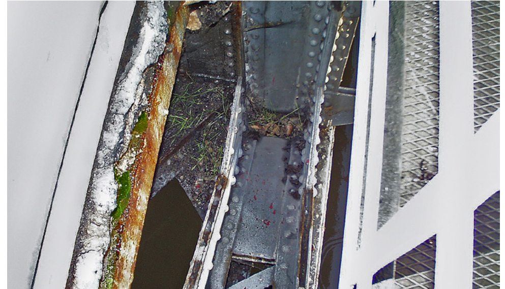
Obr. 3.116. Stav mostu před rekonstrukcí v roce 1998 Fig. 3.116 Bridge before reconstruction in 1998
