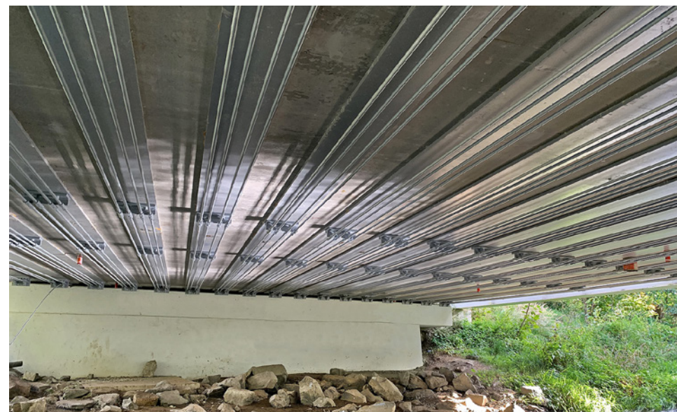
Obr. 1.52. Finální konfigurace aktivovaného zesílení Fig. 1.52 Final configuration of the activated reinforcement
