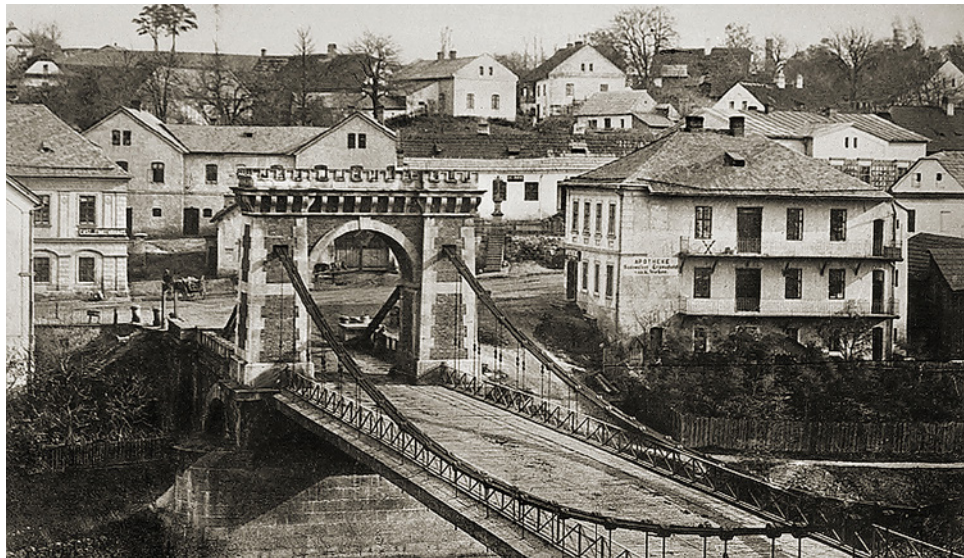
Obr. 3.124. Původní řetězový most Fig. 3.124 Original suspension chain bridge
