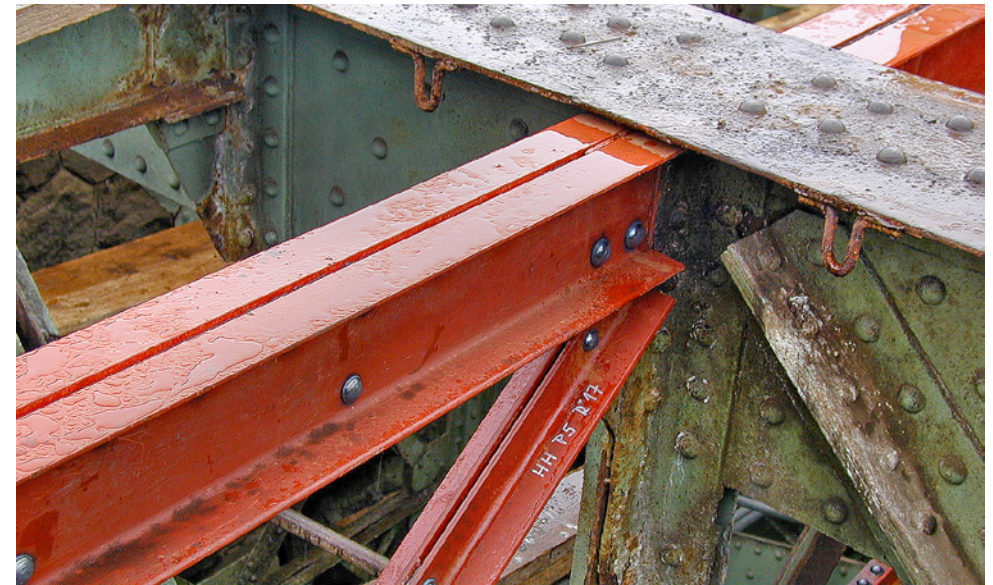
Obr. 3.107. Pohled na mostovku při rekonstrukci v roce 2000–2001 – detail příčníku Fig. 3.107 View of the bridge deck during reconstruction in 2000–2001 – detail of crossbeam
