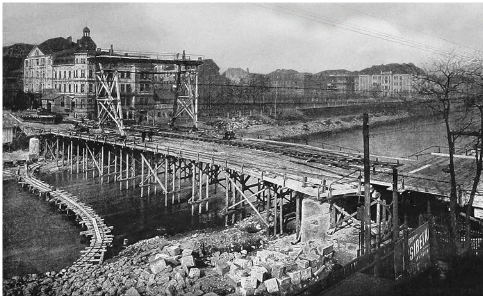
Obr. 3.126. Stavba nového mostu Fig. 3.126 The construction of the new bridge
