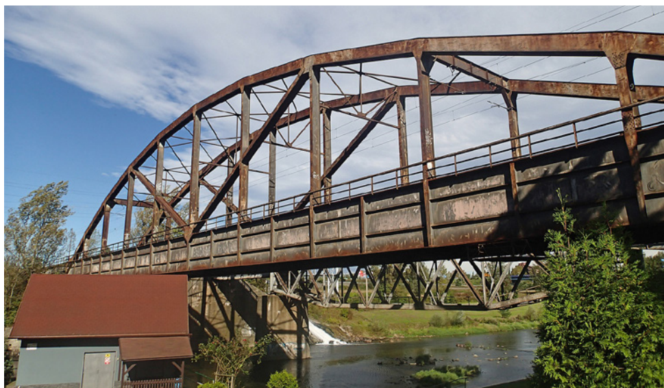
Obr. 1.33. (a, b) Tuhý trám vyztužený obloukem, tzv. Langerův trám (železniční most přes Ostravici na trati Ostrava–Kunčice – Polanka nad Odrou z roku 1964)
