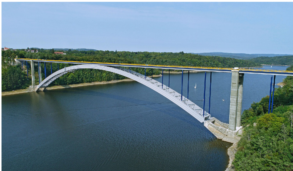
Obr. 1.31. (a, b) Obloukový most s horní mostovkou. Dvoukloubové plnostěnné oblouky (Žďákovský most přes Vltavu z roku 1967)
