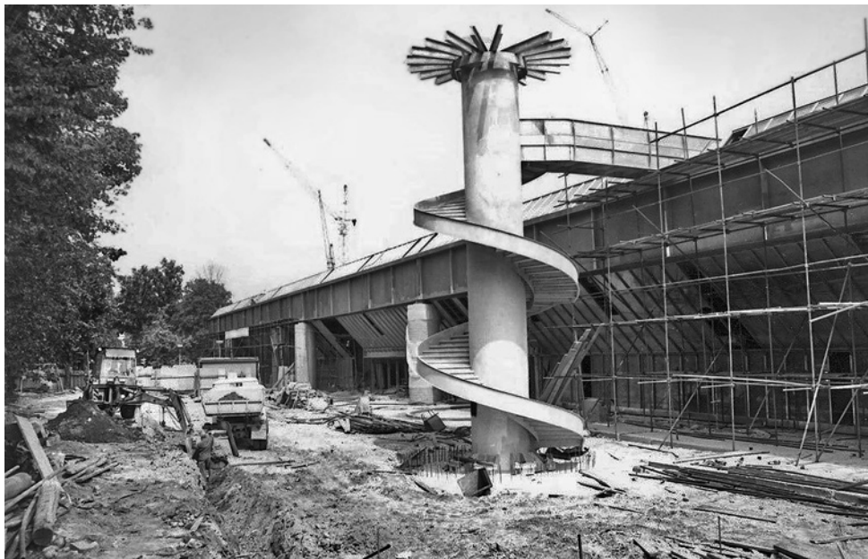
Obr. 1.45. Odbavovací hala Hlavního nádraží; (a) točité schodiště po provedení žárového nástřiku v roce 1977, (b) dokončená hala
