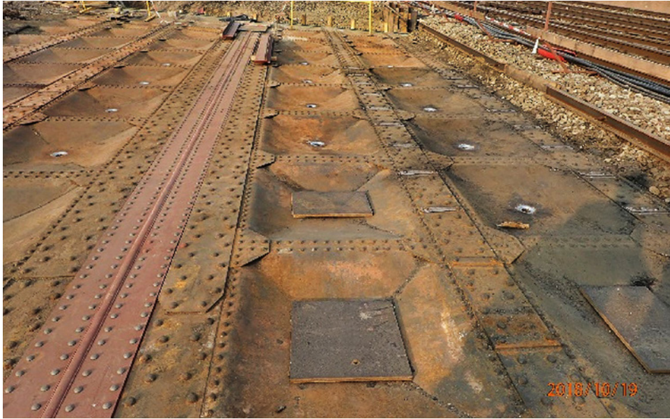
Obr. 3.18. Deska mostovky po odkrytí štěrkového lože Fig. 3.18 The bridge deck after the ballast removal
