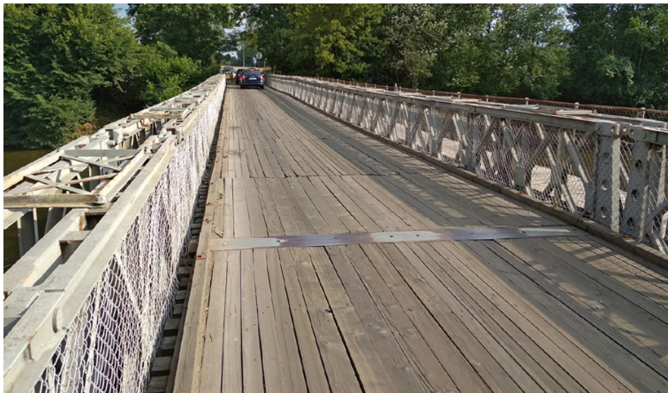
Obr. 3.147. Pohled na most po směru staničení Fig. 3.147 View of the bridge pavement
