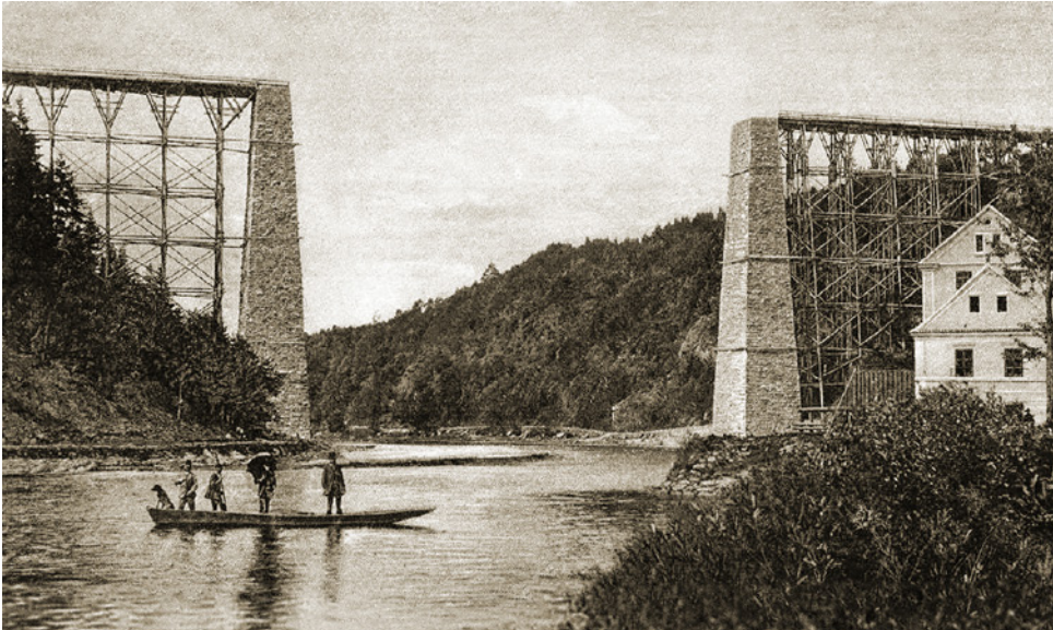
Obr. 3.2. Novinová reprodukce fotografie s pohledem na rozestavěný most před rokem 1889 (Meltzer, O.: Der Moldau-Viadukt bei Červena, in.: Allgemeine Bauzeitung, Wien 1892, pp. 65-71). Fig. 3.2 Newspaper reproduction of a photograph with a view of the bridge under construction before 1889 (Meltzer, O.: Der Moldau-Viadukt bei Červena, in.: Allgemeine Bauzeitung, Wien 1892, pp. 65-71)
