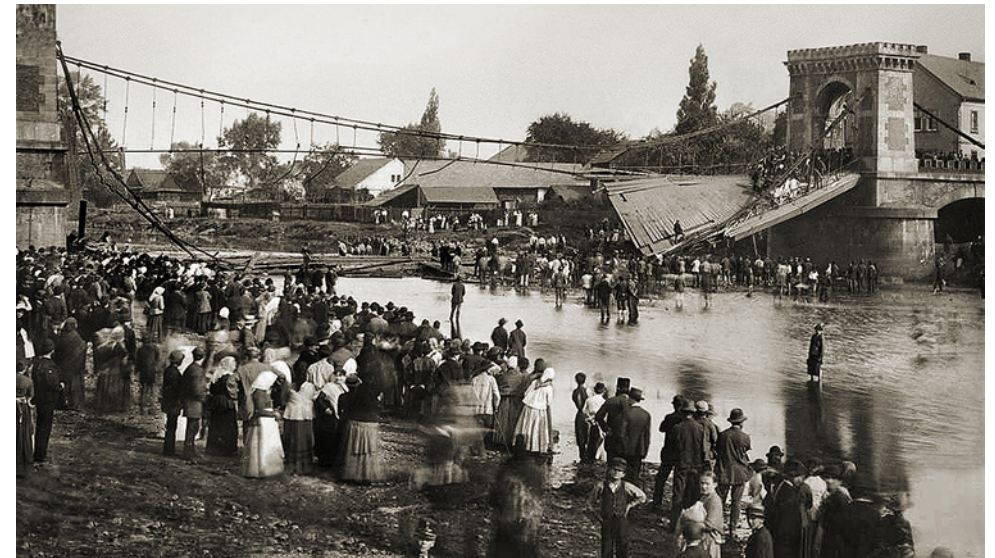
Obr. 3.125. Zřícení původního řetězového mostu v roce 1886 Fig. 3.125 Collapse of the previous bridge in 1886
