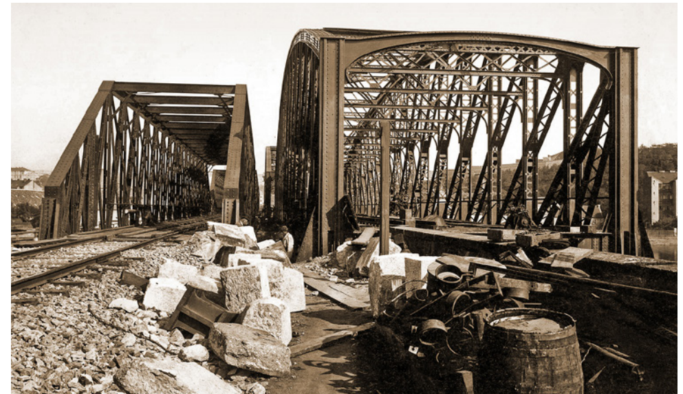
Obr. 3.22. Výměna mostu v roce 1901 (soudobá fotografie) Fig. 3.22 Replacement of the bridge in 1901 (contemporary photo)
