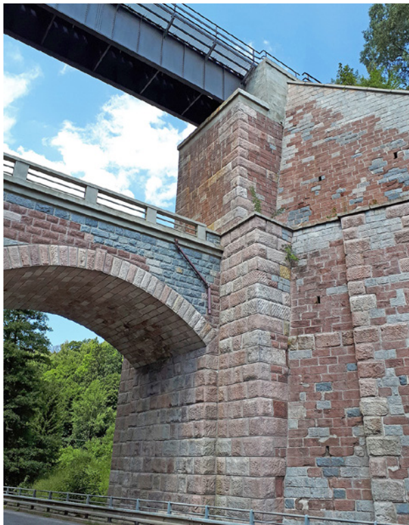
Obr. 3.48. Pohled na opěru a nosnou konstrukci Fig. 3.48 The view on the bridge abutment and superstructure
