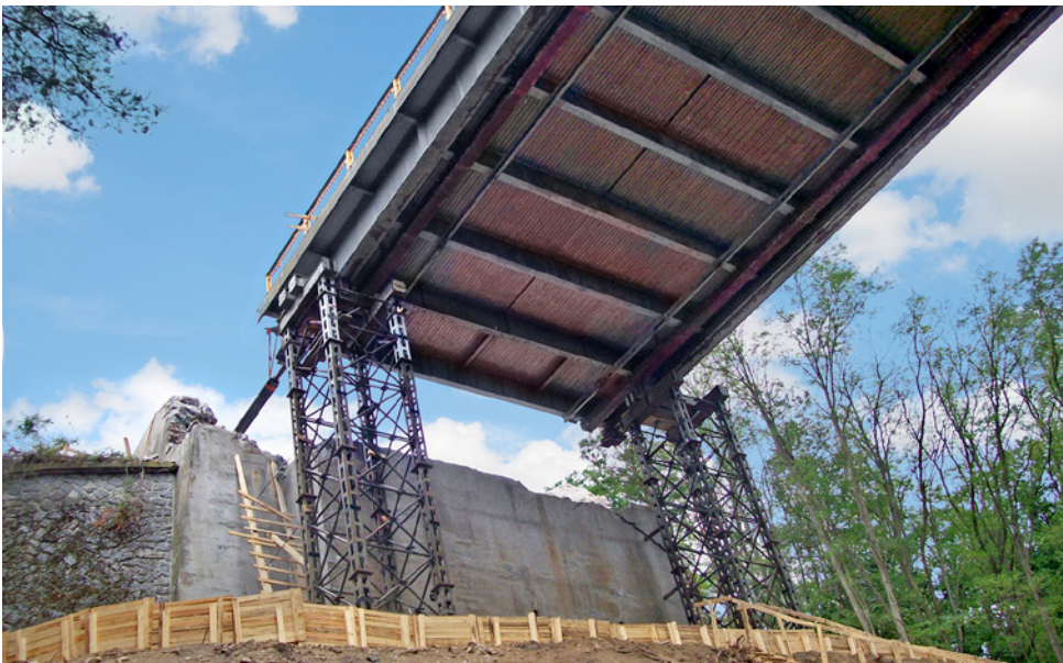
Obr. 3.165. Odbouraná horní část opěry Fig. 3.165 Demolished upper part of the abutment
