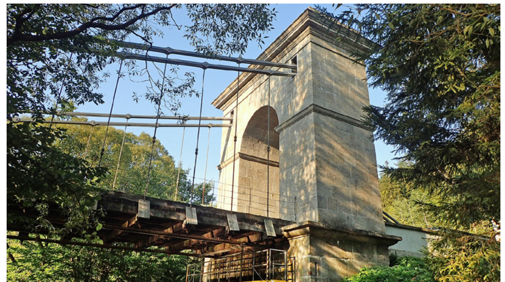
Obr. 3.63. Pohled na pylon zděný z kamenných kvádrů Fig. 3.63 View of the pylon of the bridge from stone blocks
