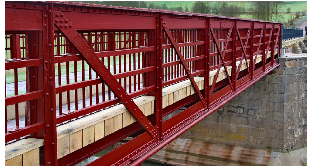
Obr. 3.82. Stav mostu po rekonstrukci Fig. 3.82 Superstructure after reconstruction
