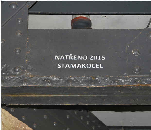
Obr. 3.100. Korozní oslabení v oblasti krčních úhelníků dolního pásu Fig. 3.100 Corrosion weakening in the bottom chord flange angles
