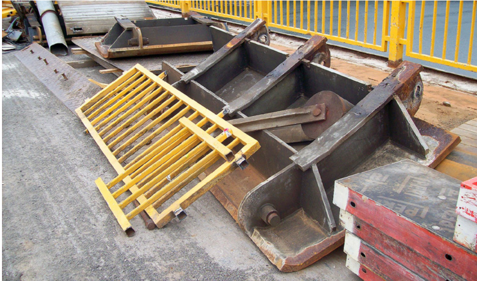
Obr. 3.161. Část vyjmutého mostního závěru a výplně zábradlí Fig. 3.161 Part of the removed expansion joints and railing filling
