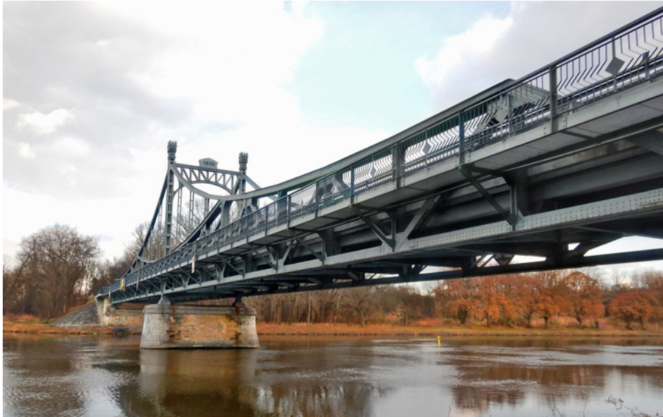
Obr. 3.121. Celkový pohled na most v roce 2021 (HPM, Pontex) Fig. 3.121 View of the bridge in the year 2021 (HPM, Pontex)
