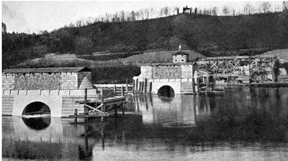
Obr. 3.104. Výstavba spodní stavby mostu Fig. 3.104 The bridge substructure construction
