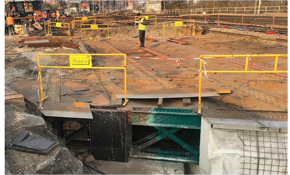
Obr. 3.19. Odhalení desky mostovky a obnova protikoroziční ochrany koncových příčníků Fig. 3.19 The bridge deck and coating of the end cross beam
