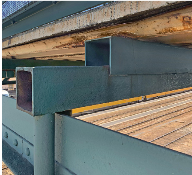
Obr. 3.170. Dodatečný příčník s rektifikací Fig. 3.170 Additional rectifiable cross-beam
