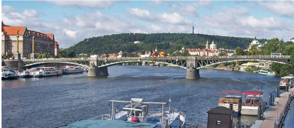
Obr. 1.30. (a, b) Obloukový most s horní mostovkou. Dvoukloubové příhradové oblouky (Čechův most v Praze z roku 1908)
