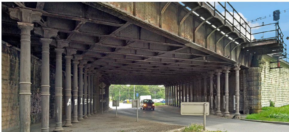
Obr. 1.23. (a, b) Plnostěnný most s horní mostovkou (železniční most Křídlovická v Brně z roku 1895)
