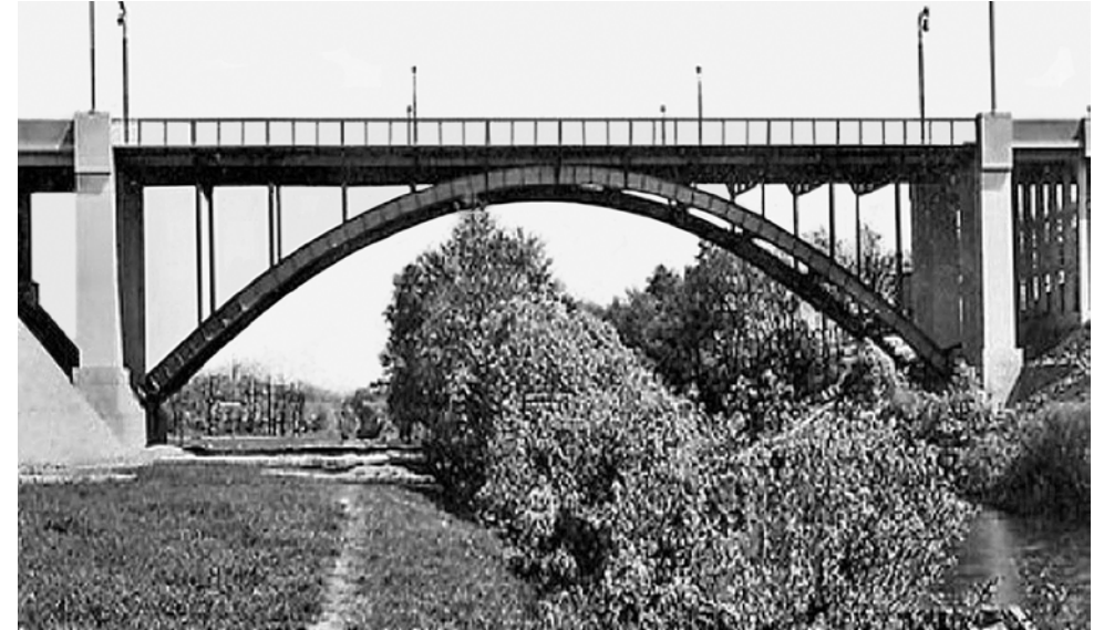
Obr. 3.137. Stav po dokončení 1933 (foto: dobové periodikum) Fig. 3.137 Bridge after built in 1933
