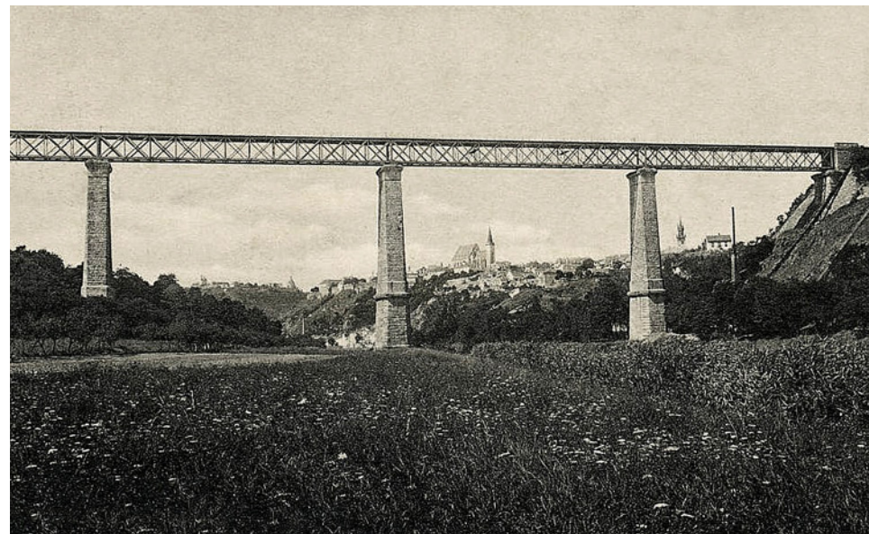
Obr. 1.21. Znojenský viadukt Fig. 1.21 Znojmo Viaduct
