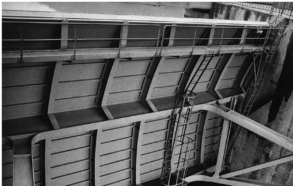
Obr. 1.39. Korunový uzávěr – přehrada Orlick Fig. 1.39 Crown closure – Orlick dam
