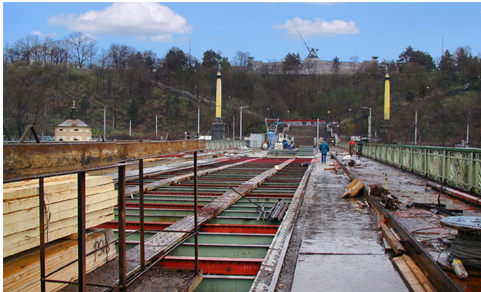
Obr. 3.106. Pohled na mostovku při rekonstrukci v roce 2000–2001 Fig. 3.106 View of the bridge deck during reconstruction in 2000–2001
