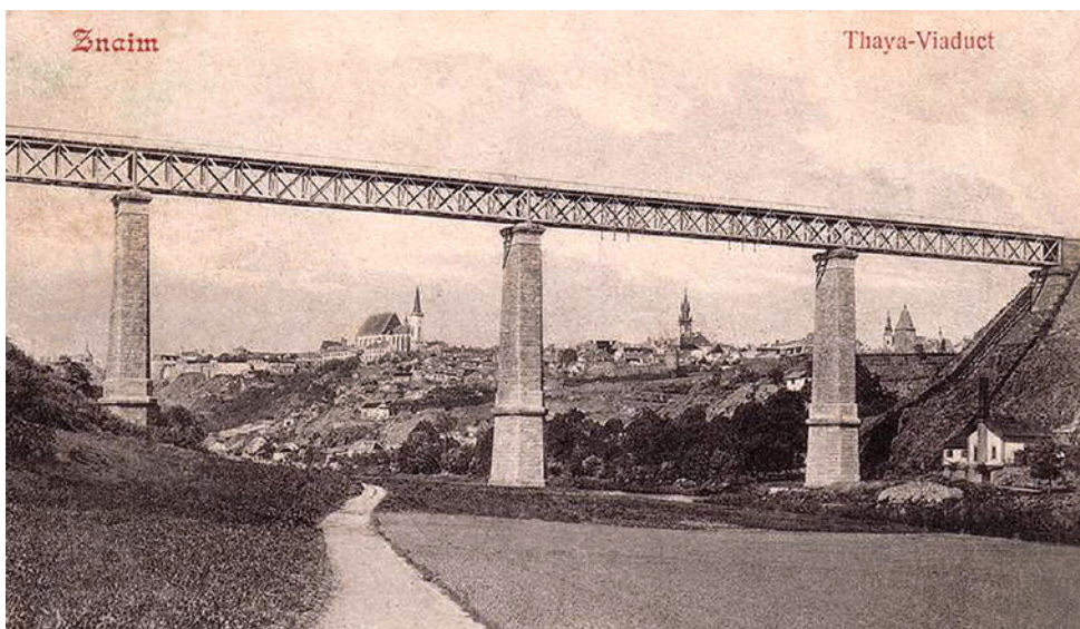
Obr. 1.27. (a, b) Příhradový most s horní mostovkou s rovnoběžnými pásy (železniční most ve Znojmě z roku 1871 a po rekonstrukci z roku 2009)
