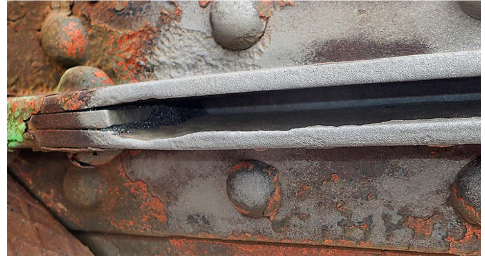
Obr. 3.29 Štěrbina mezi plechy diagonály – po tryskání ocelovým abrazivem Fig. 3.29 The gap between diagonal plates – after steel shot blasting
