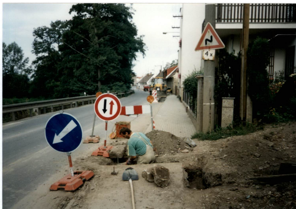
Prodloužení vodovodu kolem hlavní silnice k jezu
