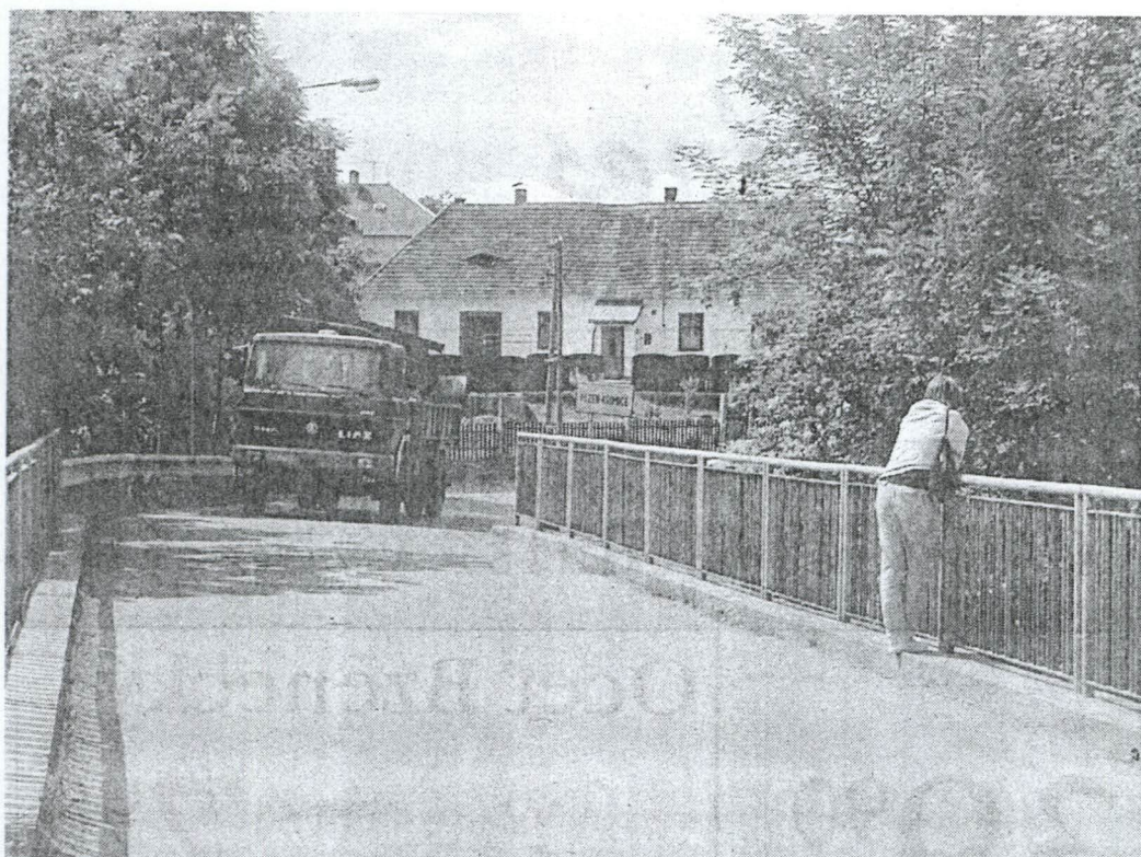
Most přes Mži v Křimicích bude posunut asi o dvanáct metrů západně a výrazně rozšířen. Zvětší se tak zároveň celá komunikace. Foto IVAN BLAŽEK
