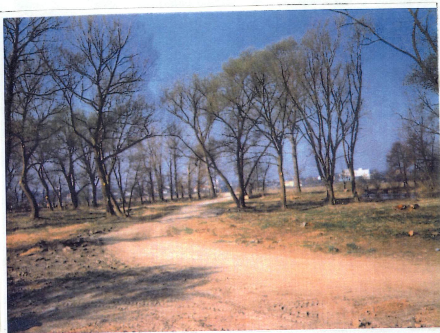
Předmostí "navážka" po úpravě, v pozadí jsou Křimice.
