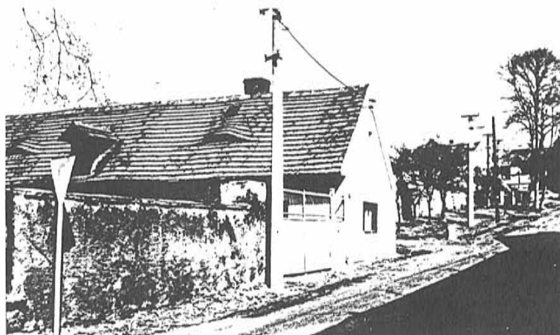
Bývalá obecní pastouška čp.13 r. 1987
