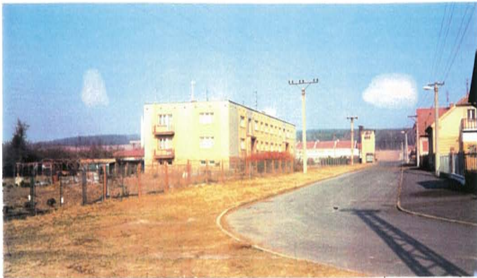
Bytový dům čp.208/209 a druhý transformátor r.1992
