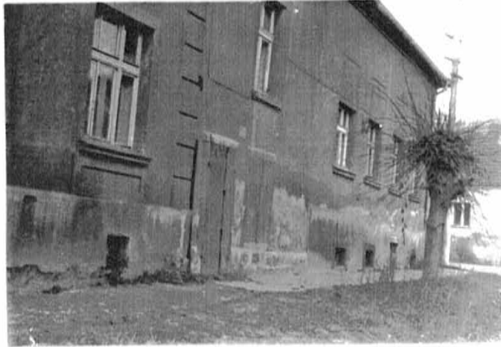
Bývalé řeznictví v budově čp.9 r.1988
