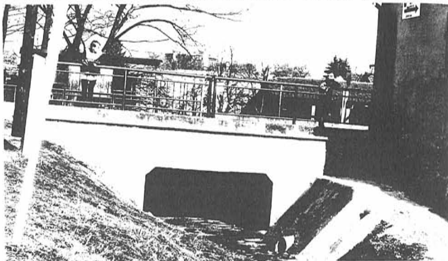
Dolní strana mostu na Radčickém potoce r.1992
